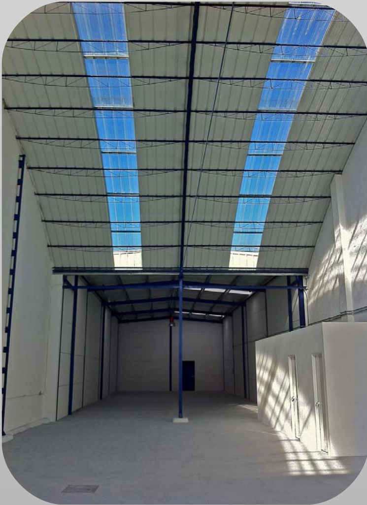
Remodelación de nave industrial en Villacarrillo. Proyecto y obra Proboges Industrial 2009
