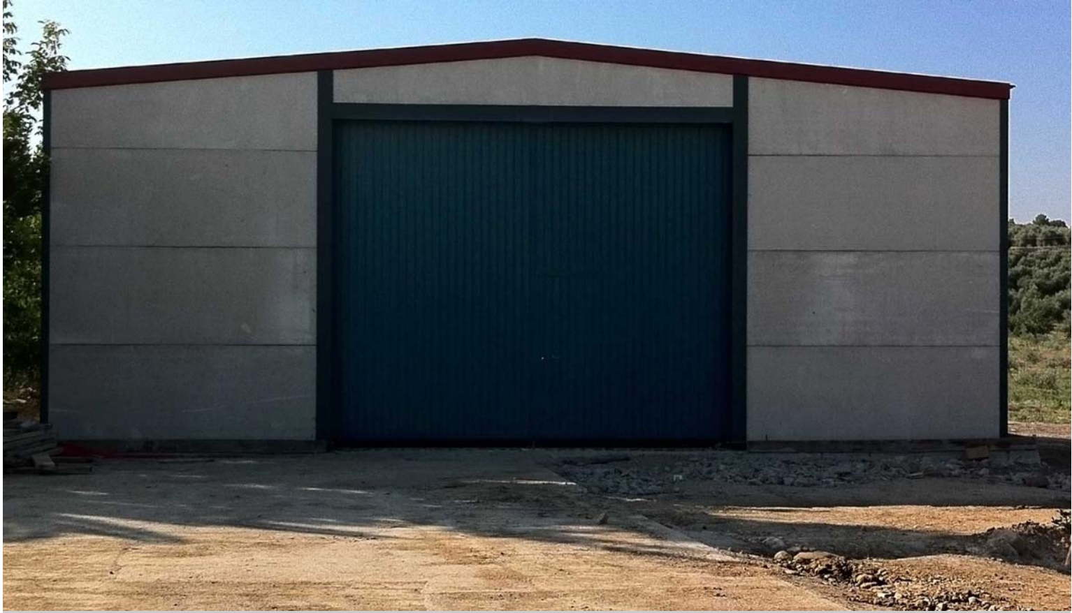
Nave agrícola en Rus (Jaén) 12x18 m.
